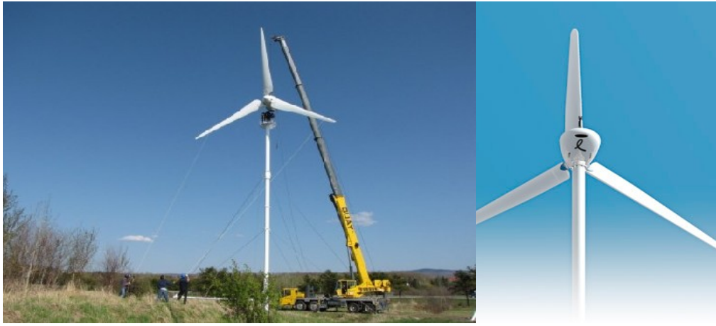
איור 9: Endurance E-3120 קוטר להבים 18 מטר, הספק מותקן כ-45 Kw ב-9 מטר בשניה
